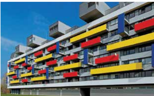
Stambena zgrada "Mondrian" Bratislava, Slovačka
